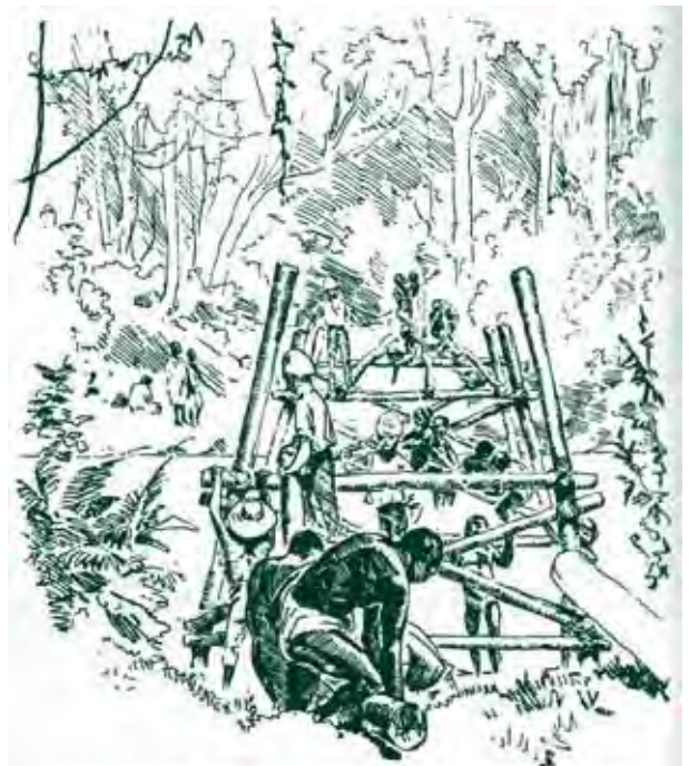
Costruimmo non meno di duecento ponti, con materiale trovato in loco.
