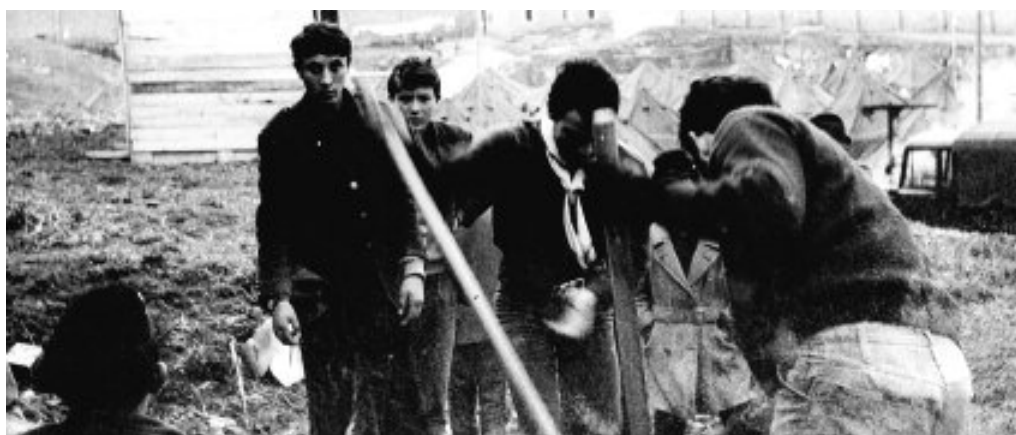
Scout al lavoro dopo il terremoto del Belice, 1968
