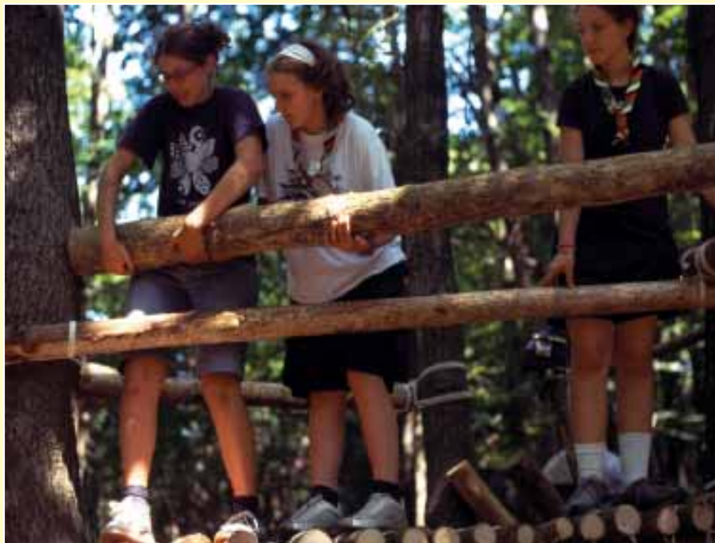
■ ...nuovo sentiero in costruzione
