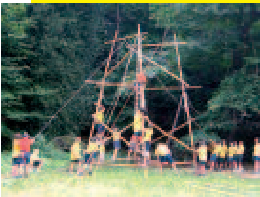
Costruzione della torre
